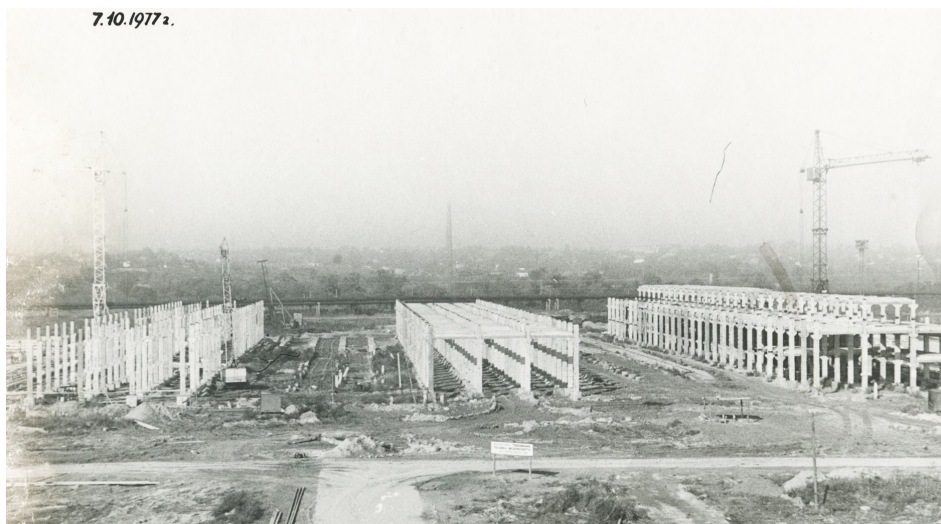
Рис. 1. Начало строительства одного из самого крупного в мире производства ядерно-чистого циркония
