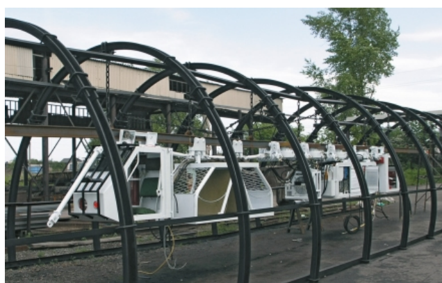
Рис.15.9. Подвесная дорога ДП-155
