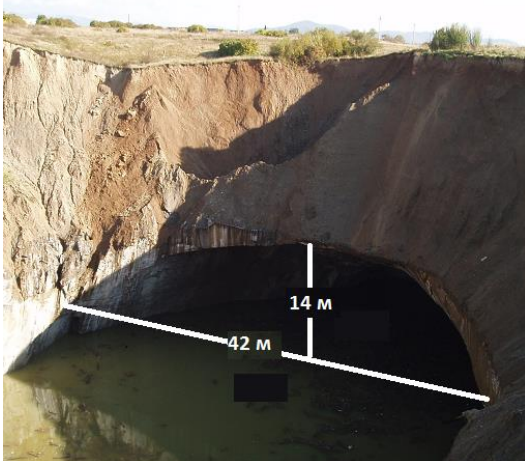
Рис.2. Склепіння над обваленими ціликами (шахта №7 в Солотвині)
