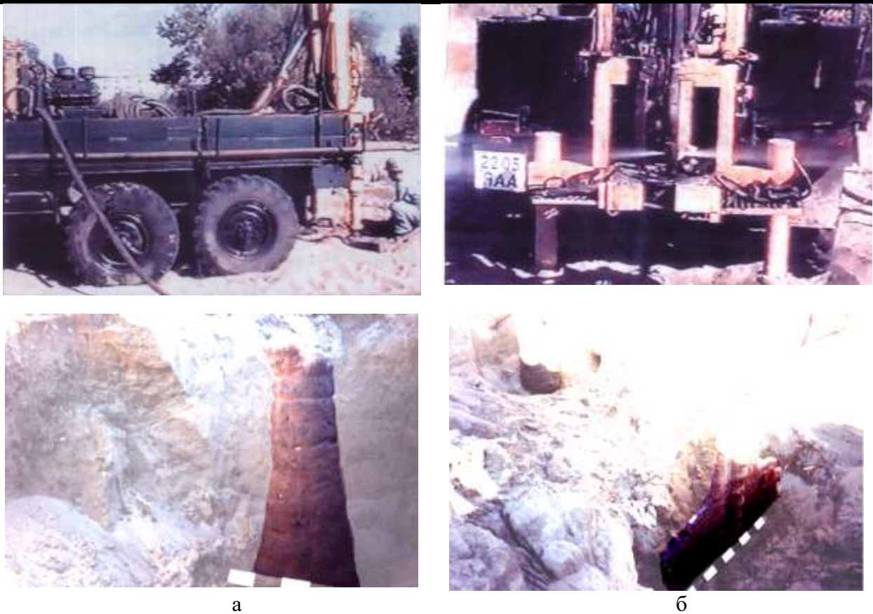
Рис. 3. Установка и результаты экспериментальных работ по струйному закреплению дисперсных пород с вращением (а) и без вращения струйного монитора (б)
