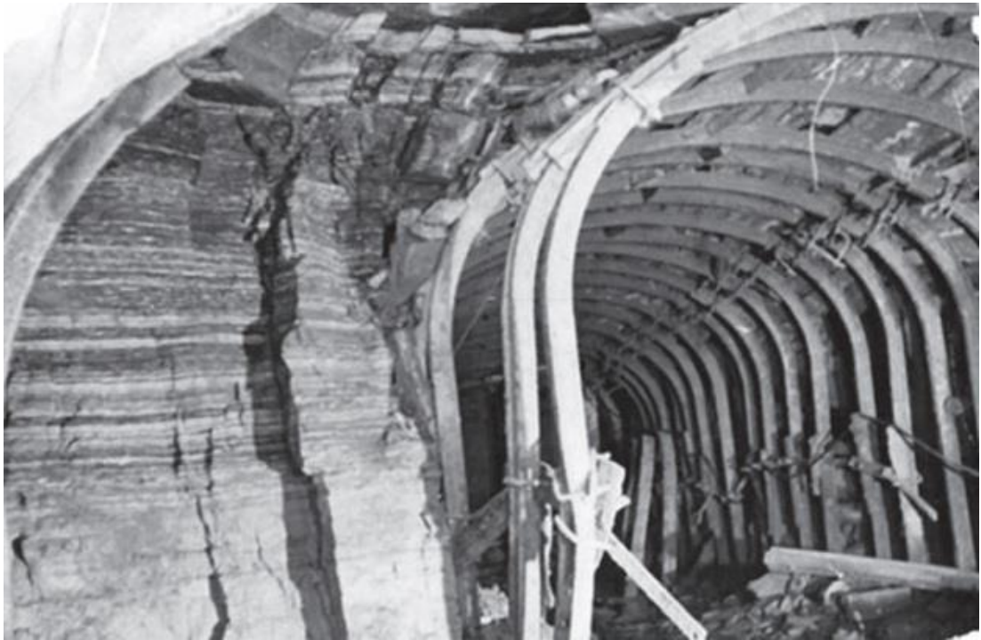
Рис. 1.3. Розшарування порід в зоні приконтурного масиву[11]
