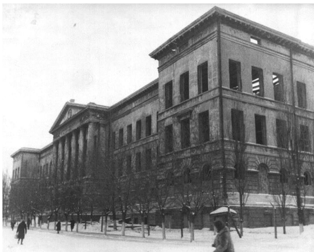
Институт уже работает. Восстанавливается главный корпус. 1948 год
