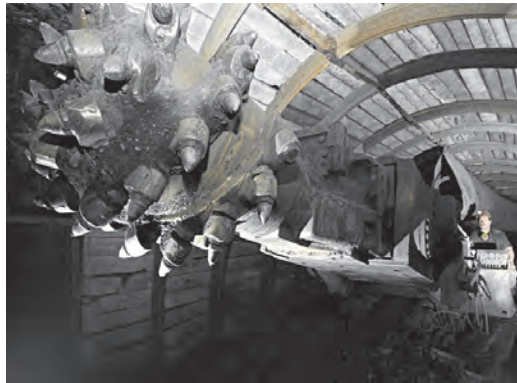
Рисунок б.б – Проведення гірничої виробки комбайном
