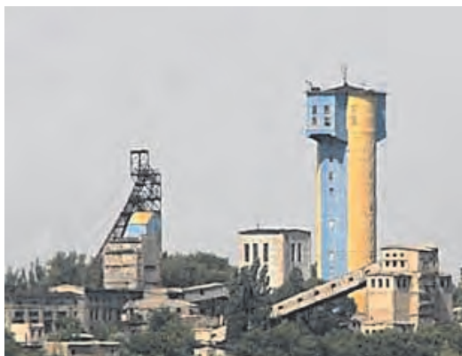
Рисунок 4.1 – Типові копри вугільної шахти
