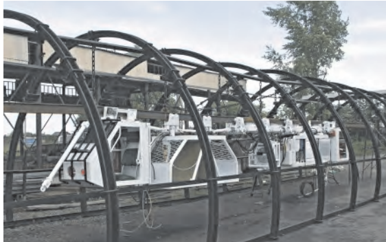
Рисунок 16.9 – Підвісна дорога ДП-155
