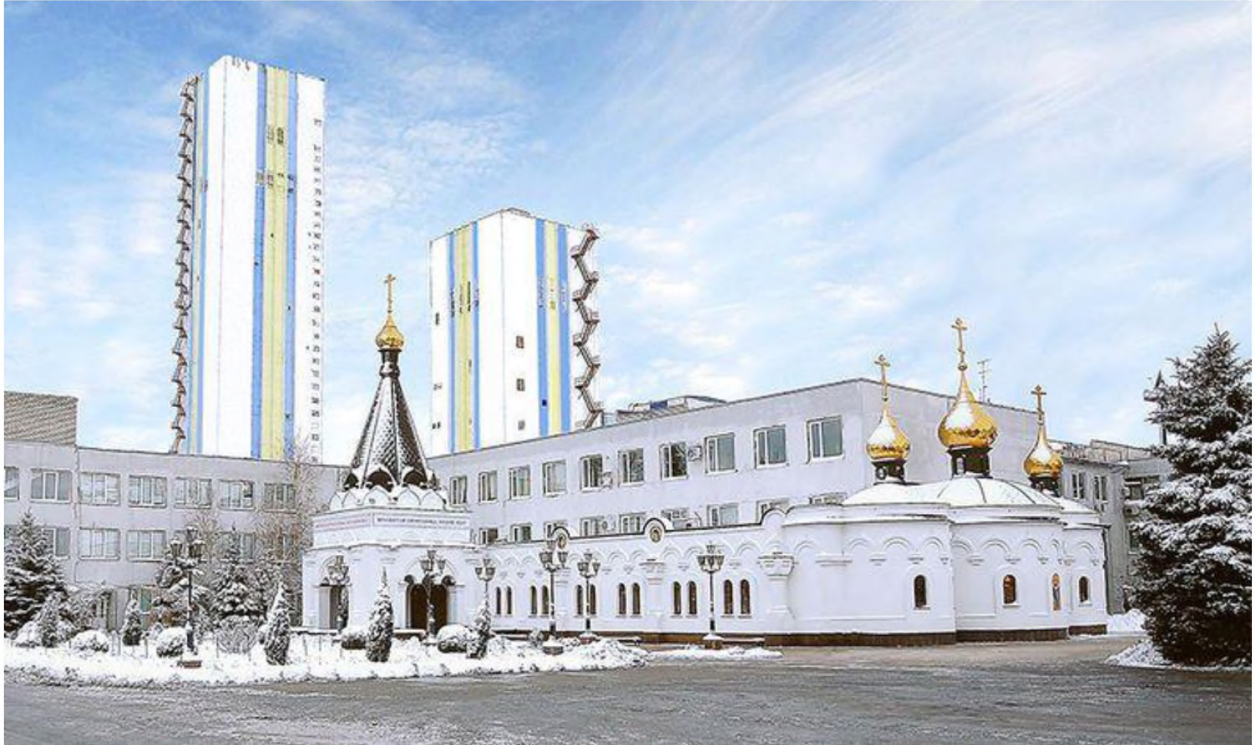
Рисунок 1.2 – Загальний вигляд шахти зі сторони двору АБК
