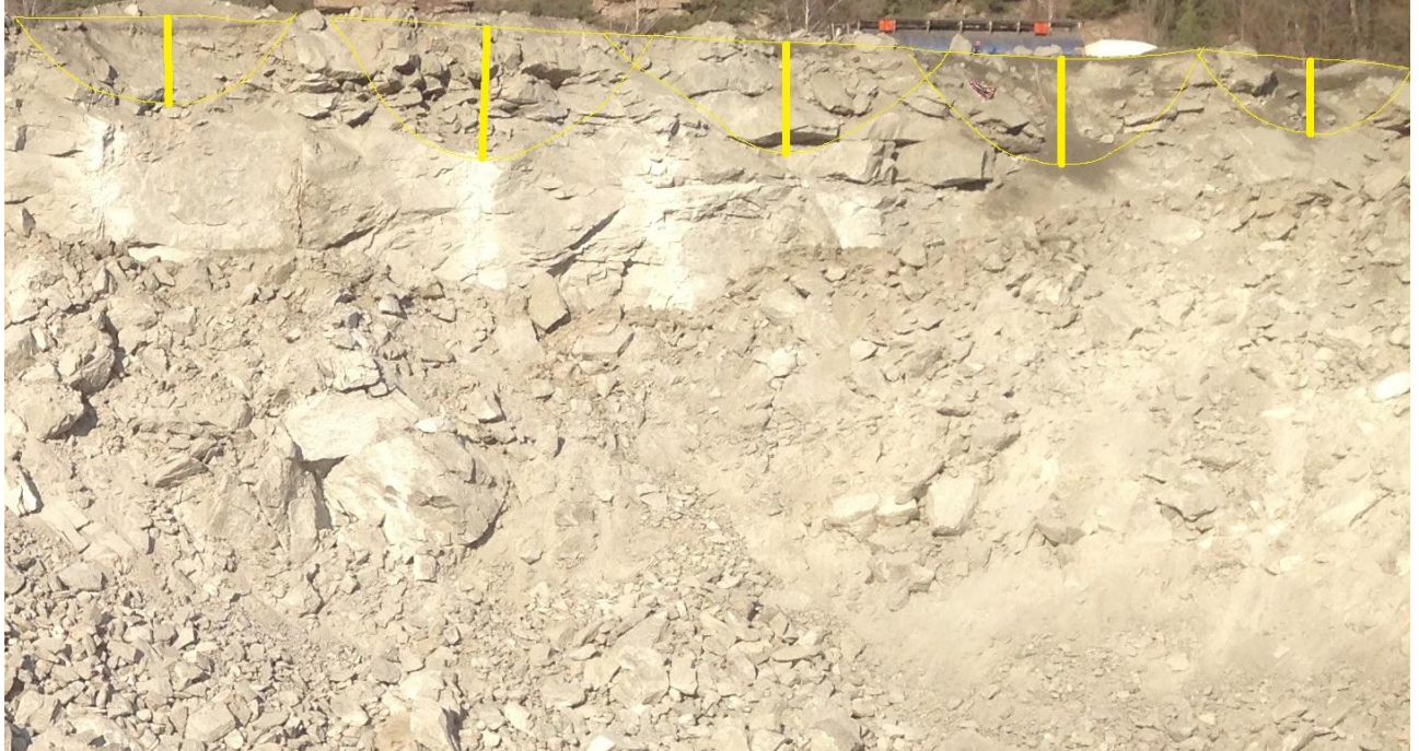
Рис. 3.7 Схема розміщення деформаційних зон на верхньому горизонті в районі перебури при застосуванні свердловинних зарядів діаметром 250 мм
