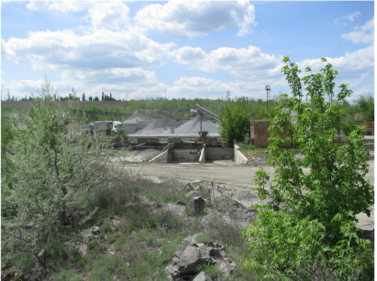
Рис. 2.5 Дробарно-сортувальний комплекс кубовидного щебеню ДСК рядового щебеню
