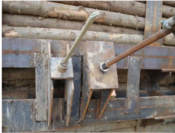
Рисунок 2.6 – Кріплення ґрунтового анкера до обв'язки [83]
