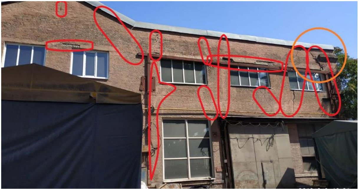
Фото І.20 – Тріщини, відшарування захисного шару бетону, вихід з проектної площини фрагментів цегляної кладки (Фасад Е-А)
