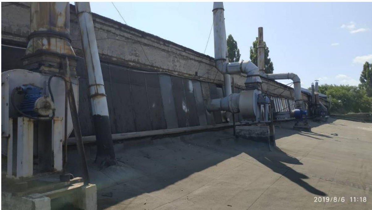
Фото І.7 – Загальний вигляд покрівлі з фасаду 17-1
