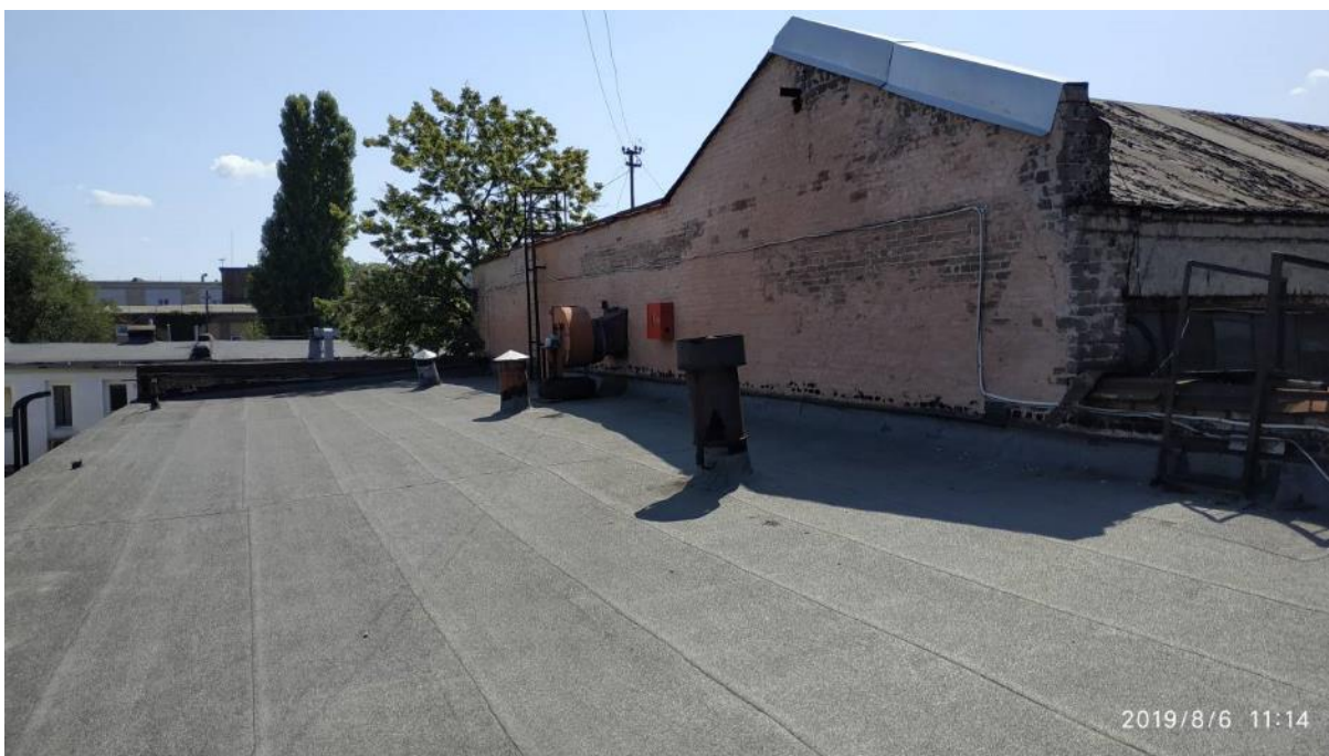
Фото І.8 – Загальний вигляд покрівлі з АПК
