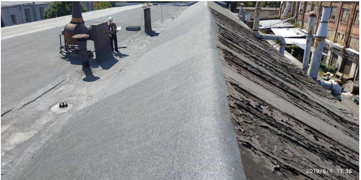
Фото І.6 – Загальний вигляд і покрівлі цеху з боку АПК
