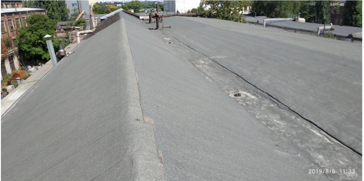
Фото І.5 – Загальний вигляд покрівлі цеху в сторону АПК
