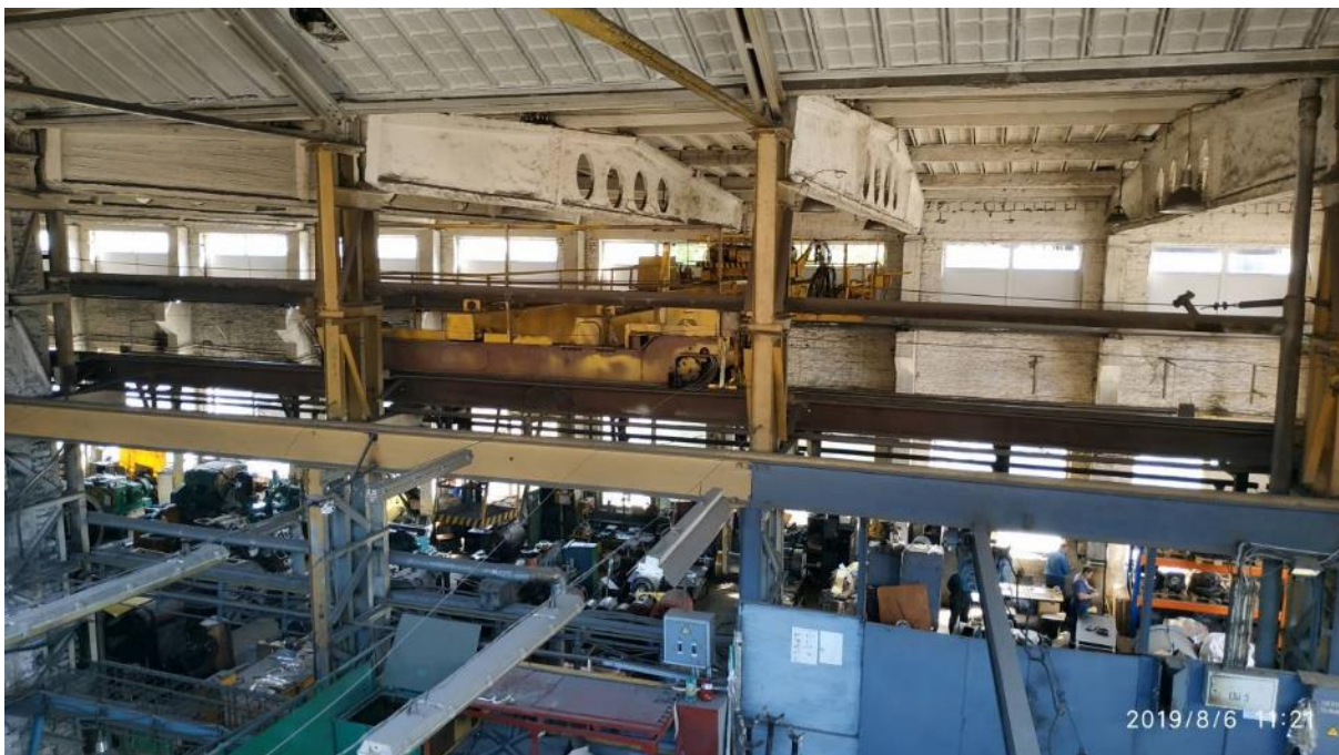
Фото І.10 – Загальний вигляд цеху
