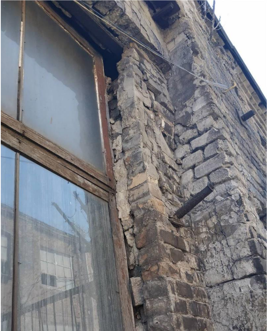
Фото І.26 – Виколювання і руйнування цегляної кладки
