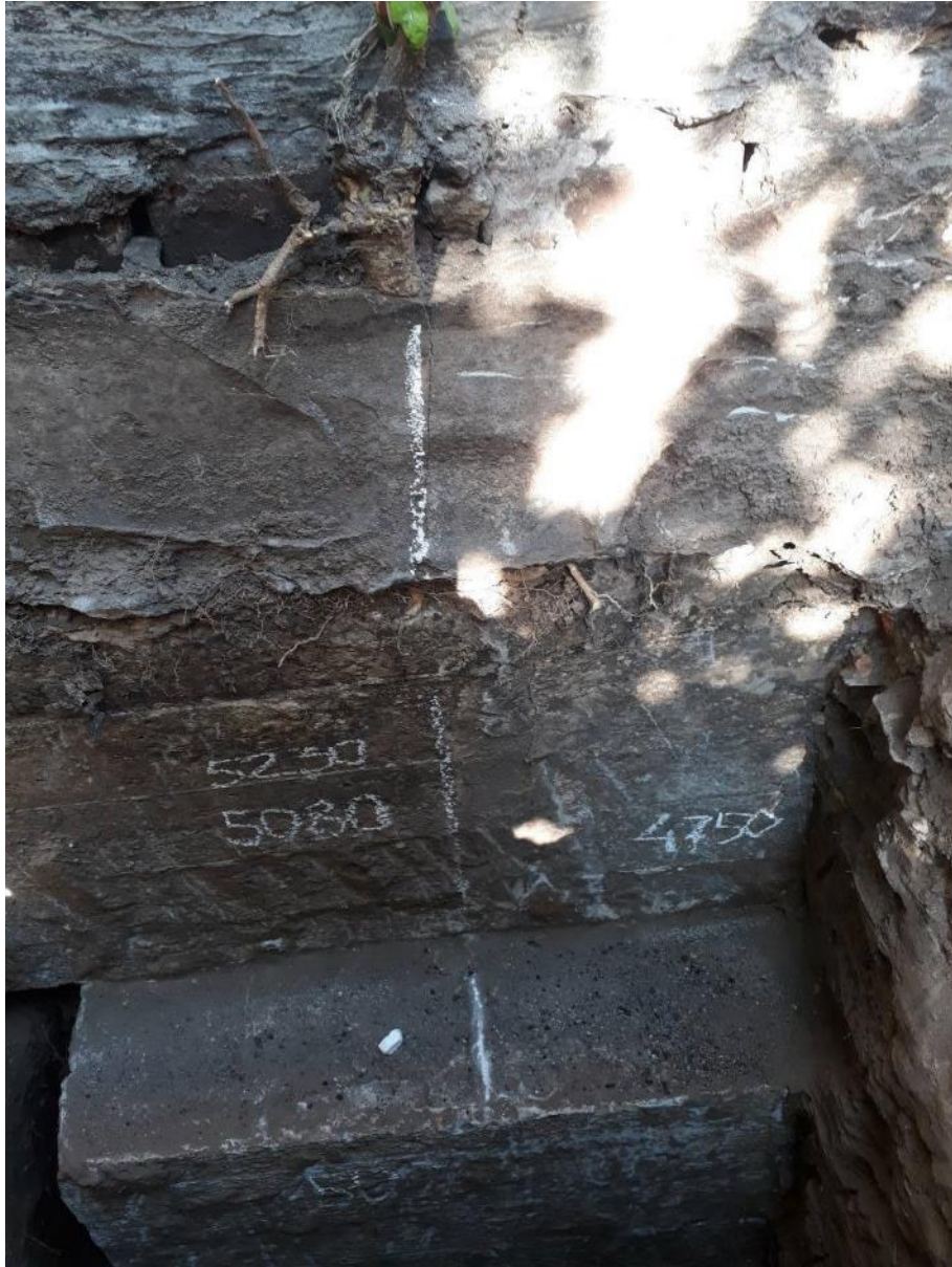
Фото I.52 – Тип фундаменту по ряду А
