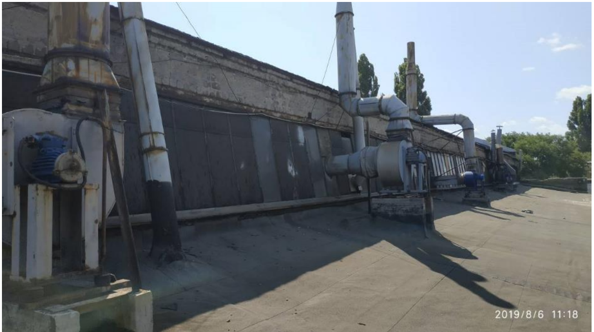
Фото І.35 – Частина покрівлі з фасаду 17-1
