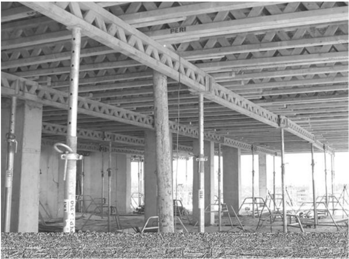
Рисунок 3.2 – Система балочной опалубки для перекрытия
