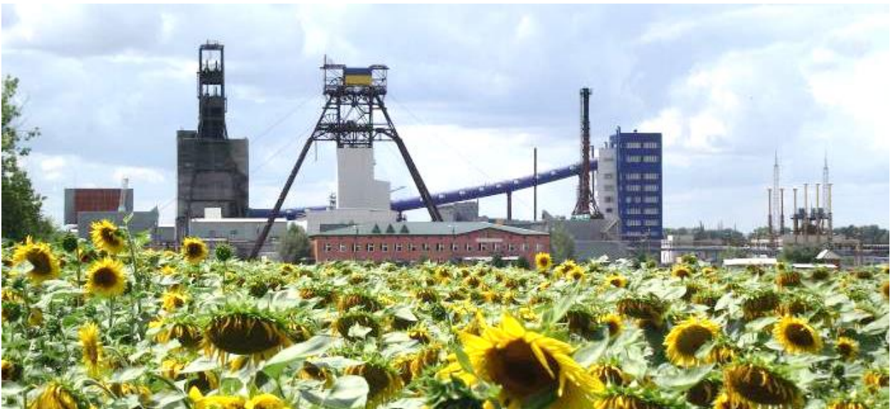
Рисунок 1.3 – Загальний вид ВПС №2 Блоку №10
