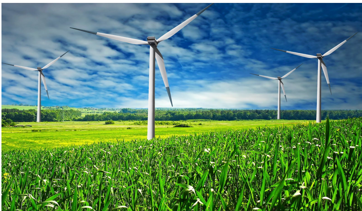
Рис 1.2 Загальний вигляд вітряної електростанції
