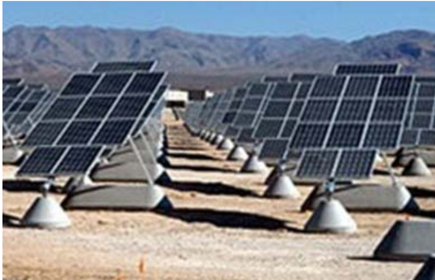
Рисунок 1.4 - Трекер з вертикальною віссю
