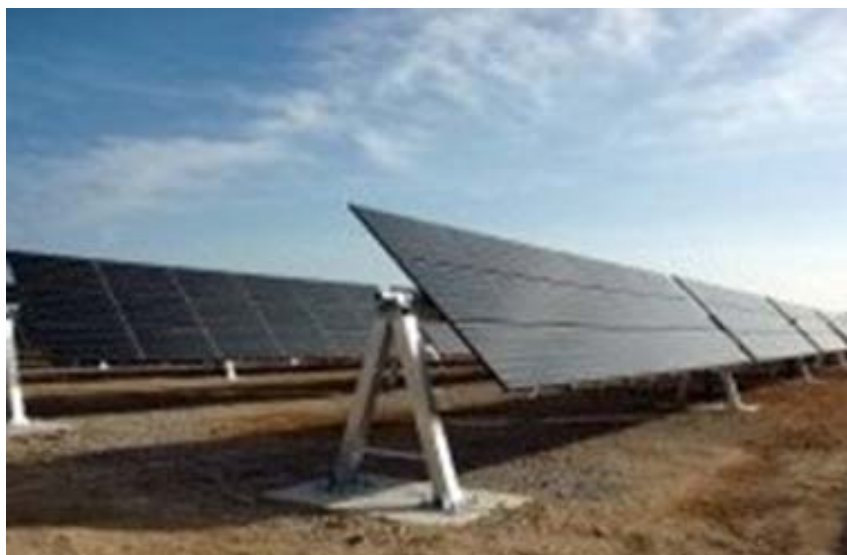
Рисунок 1.3 - Трекер з горизонтальною віссю
