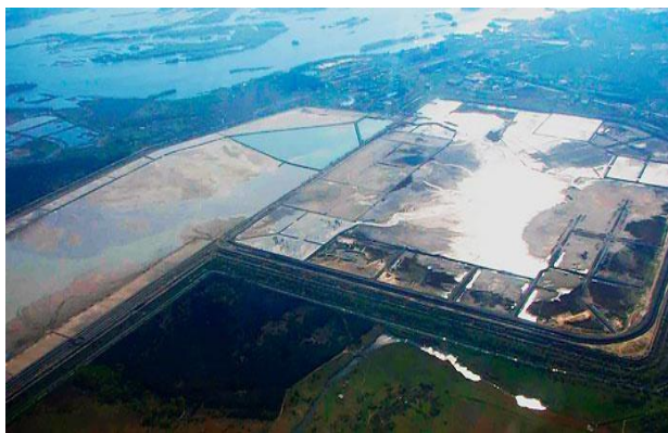
Рисунок 1.11 – Загальний вигляд хвостосховища ПГЗК.
