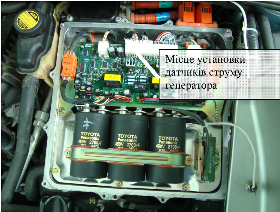
Рисунок 4.3 – Місце встановлення датчиків струму
