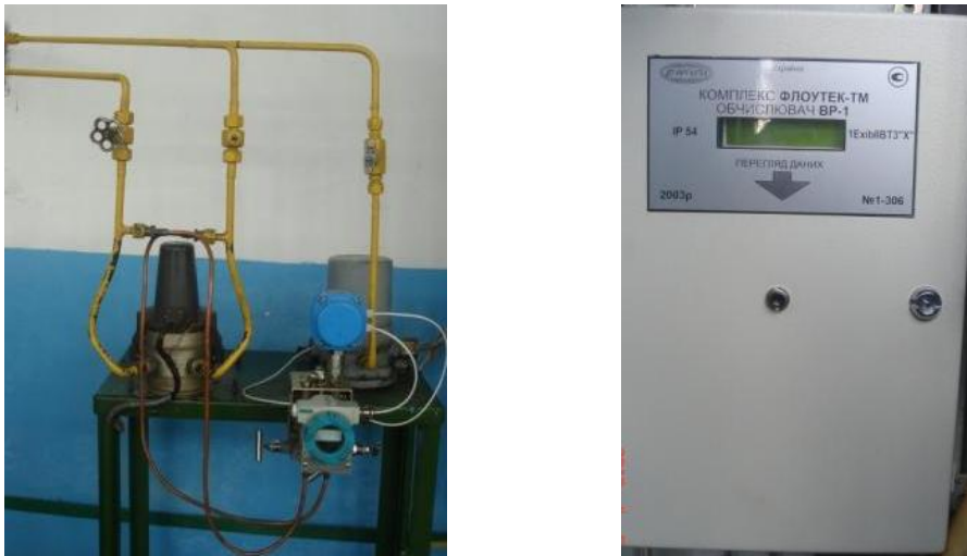
Рис. 1 – Пробне встановлення комплексу на КС «Краснопілля»
