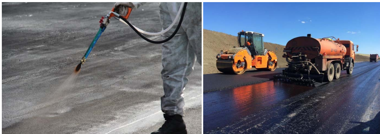
Рисунок 5.6 – Типові способи вприскування бітумної емульсії на поверхню (вручну та з використанням спеціальної автомобільної техніки)
