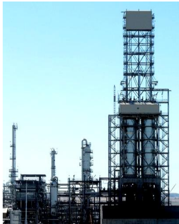
Рисунок 11.17 – Установа уповільненого коксування на Херсонському НПЗ
