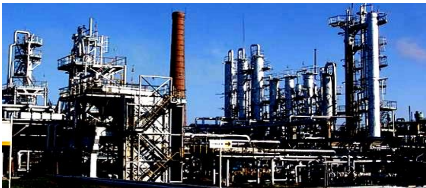
Рисунок 11.29 – Установа гідроочищення вакуумного газойлю (ВАТ «Одеський НПЗ»)
