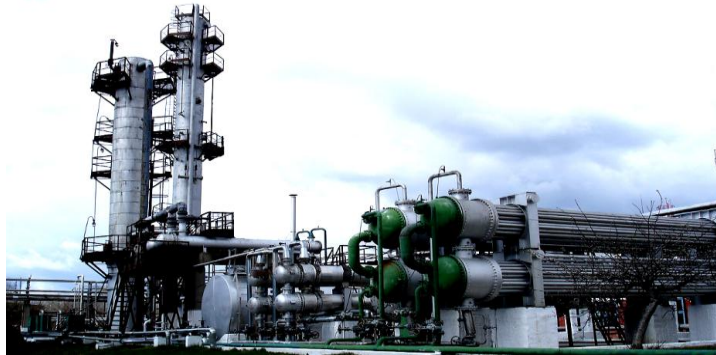
Рисунок 11.36 – Установа осушення природного газу Гнідинцівського ГПЗ (ВАТ «Укрнафта»)
