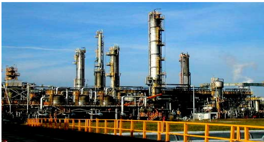
Рисунок 11.10 – Блоки атмосферної перегонки нафти та вторинної перегонки бензину Кременчуцького НПЗ (АТ «Укртатнафта»)
