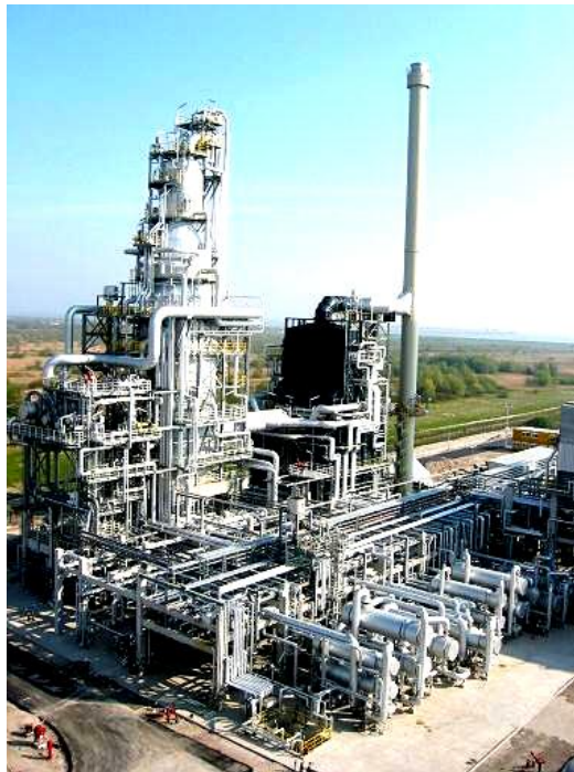
Рисунок 11.11 – Блок вакуумної перегонки мазуту установки первинної перегонки нафти на Херсонському НПЗ (НК «Альянс»)
