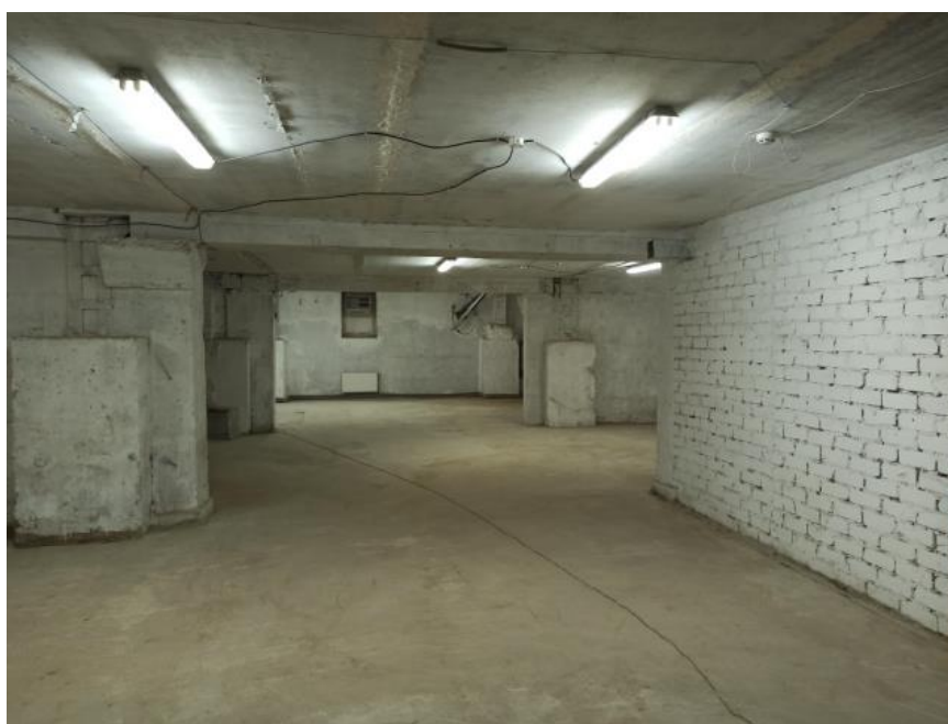
Рисунок 2.7 – Підвал першого корпусу комплексу «Дубовий гай»
