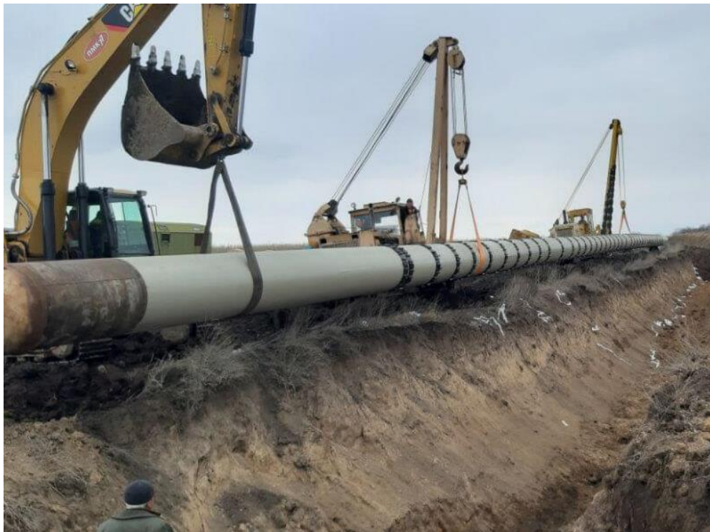
Рис. 1 Будівництво газопроводу – «ПМК-77»
