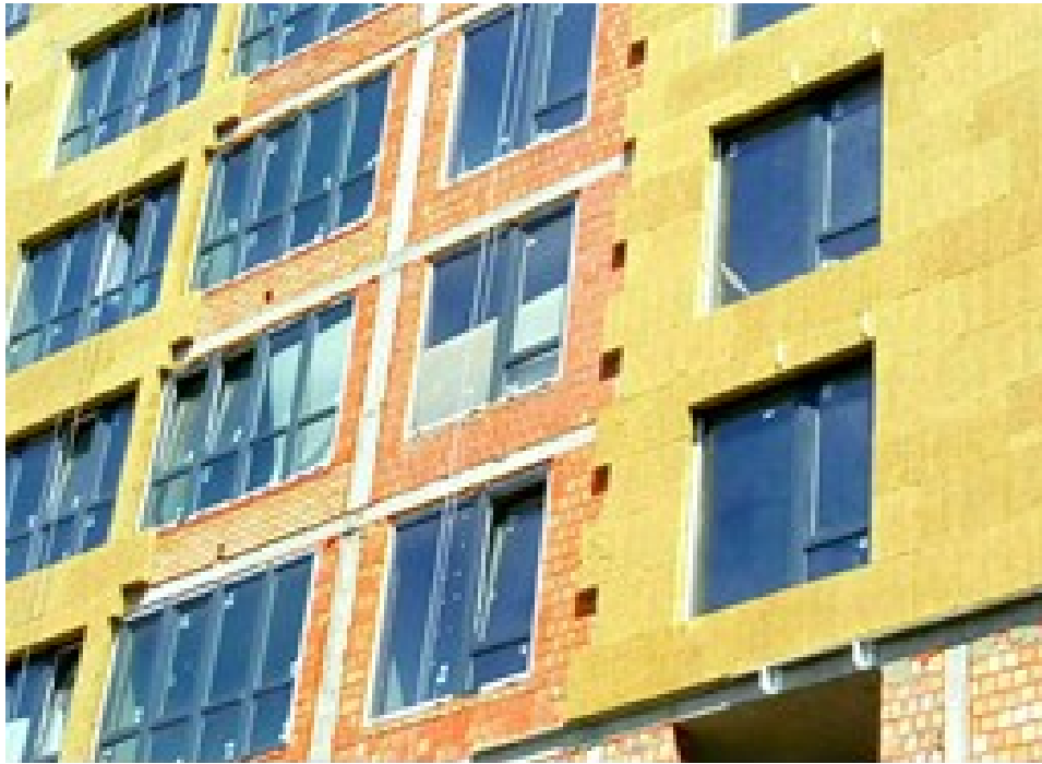
Рисунок 3.1 – Застосування мінеральної вати, сформованої у плити, поверх цегляної стіни під час поточного промислового утеплення фасадів; (процес формування утепленого фасаду поверх стіни з червоної цегли в новобудові)
