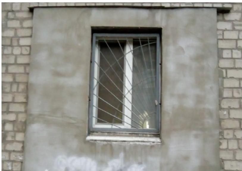
Рисунок 2.1 – Вигляд фрагментарного утеплювача товщиною до 10 см на цегляній стіні будинку
