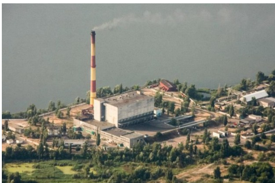
Рисунок 1.14 – Сміттєспалювальний завод "Енергія" в м. Києві
