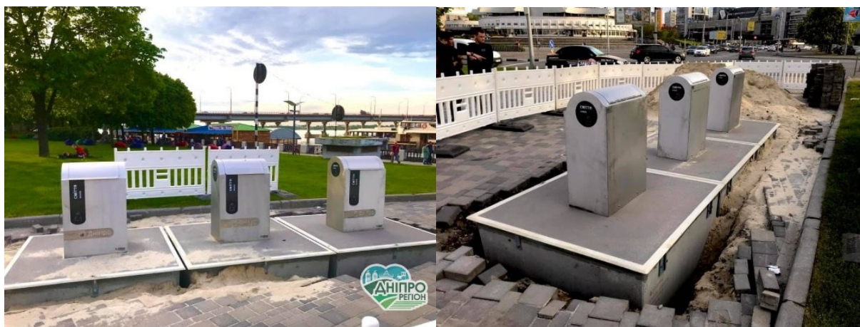
Рисунок 2.2 – Підземний контейнер вміщує 3–5 разів більше відходів, які пресуються під власною вагою
