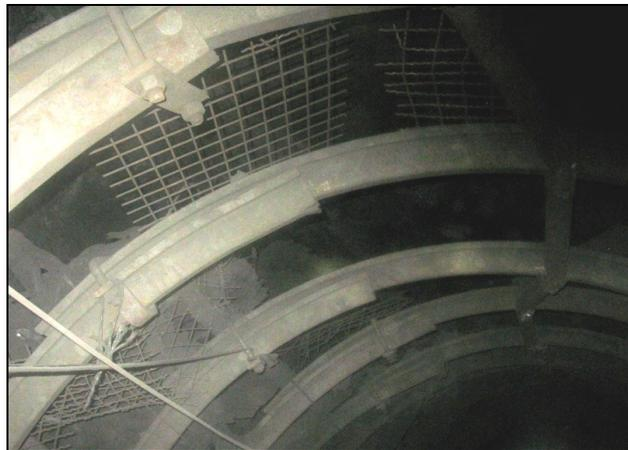
*Рис. 3. Разрушение стоек арочной крепи*
