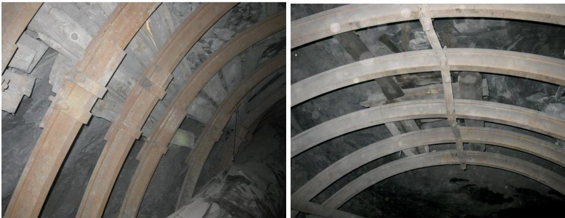
*Рис. 2. Затяжка кровли пром. штрека 206-й западной лавы*
