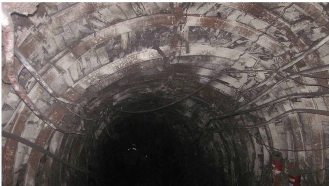
Рис. 5. Пример деформации крепи выработки
