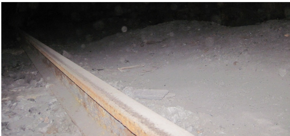
Рис. 7. Состояние пород почвы 18-го южного конвейерного штрэка пл. II в районе ПК15
